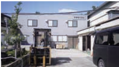
整理整頓・掃除が行き届いた工場
