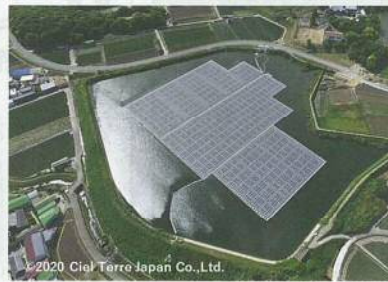
©2020 Ciel Terre Japan Co., Ltd.
