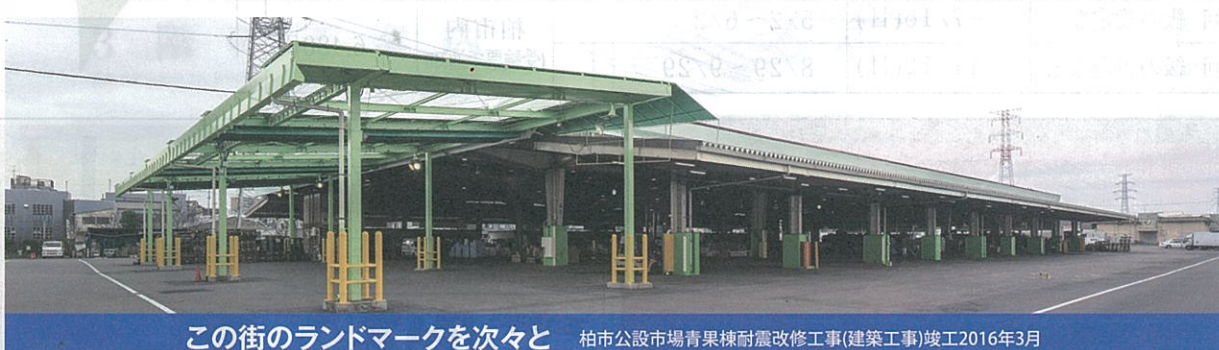
この街のランドマークを次々と 柏市公設市場青果棟耐震改修工事(建築工事)竣工2016年3月
