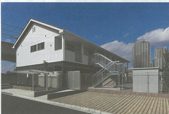
柏市 保育園 平成28年3月竣工
